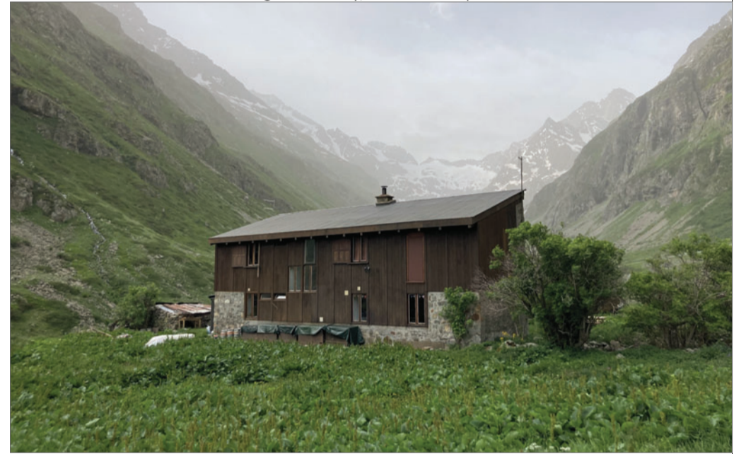
Photographie n°2, vue de "l'extension de 1968" du refuge de la Lavey, en arrivant depuis le Nord-Ouest
