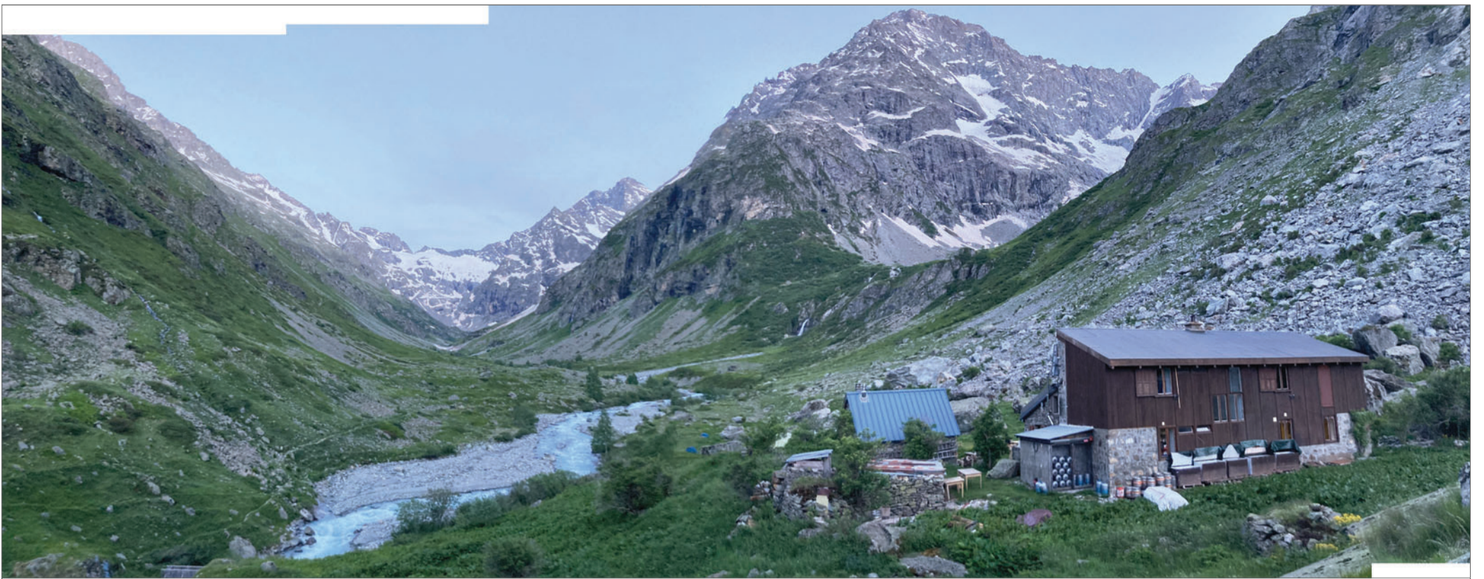
Photographie n°1, vue de "l'extension de 1968" du refuge de la Lavey et du hameau, depuis le Nord-Est
